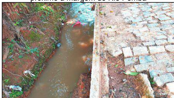
Figura 29: Drenagem superficial e construções próximo à margem do Rio Pomba
