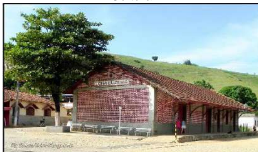
Figura 7: Antiga Estação Ferroviária - Centro Cultural
