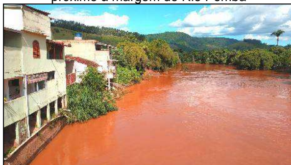
Figura 30: Drenagem superficial e construções próximo à margem do Rio Pomba
